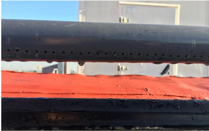
Ilustración 51. Tubo distribuidor para funcionamiento de agua por fuera
